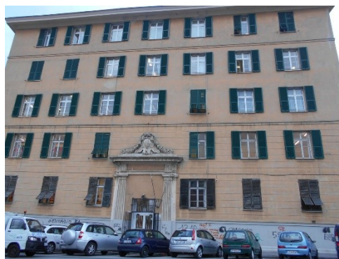
Figura 1.1 - Particolare della facciata principale
