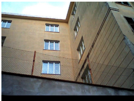
Figura 2.4 – Rilievo termografico dei serramenti
