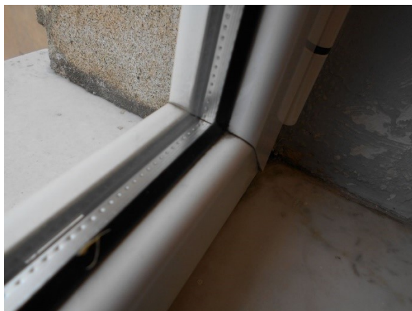
Figura 2.2 - Particolare dei serramenti in metallo e vetro doppio – dettaglio angolo vetro
